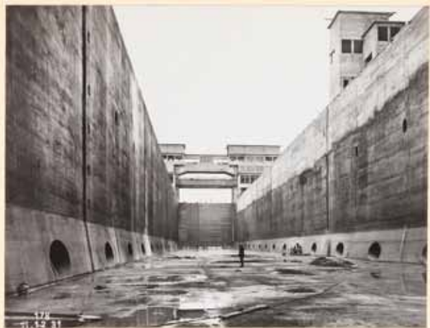
GRAND SAS AVEC PORTE AVANT (Vue prise d'avant)
