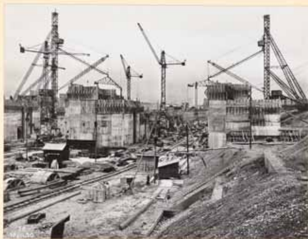
BETONNAGE DES BALOYERS A LA TETE AVANT (Chantier vu d'avant)
