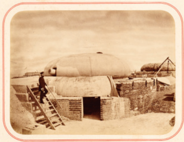
H. GRUBER, EISENGIEßEREI & MASCHINENFABRIK PÖCKAU-MAGDORF. Fort Langlütjen, Thurm II.
